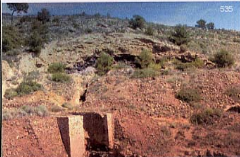
Foto 8.1. Mina Nueva Vulcano (Sierra de Carrascoy). Labor en dirección, sobre horizonte mineralizado
