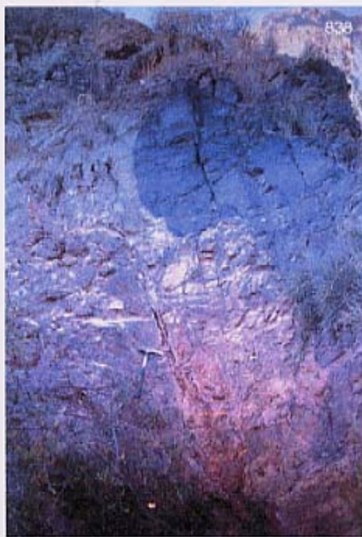
Foto 2.8. Fracturas y alteración
